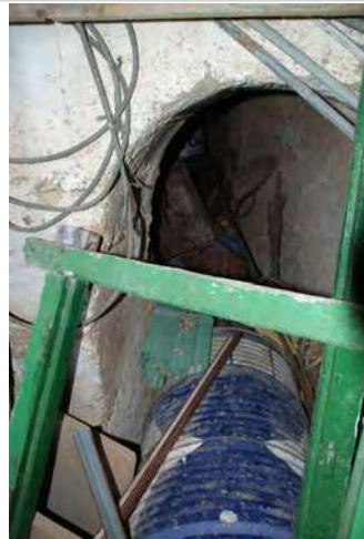
Interior. Tunnel de comunicación.
